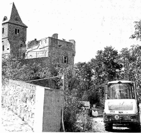
Baumaschinen sind seit einigen Wochen auf Burg Frankenstein im Einsatz. Vor allem das Mauerwerk wird ausgebessert. FOTO: MARC SCHÜLER
